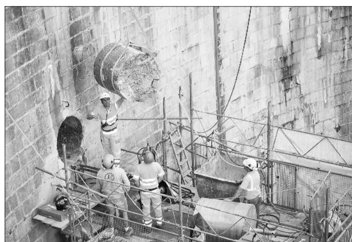
Pour pouvoir effectuer les travaux, le lac a été abaissé à son plus bas niveau depuis 1967.
